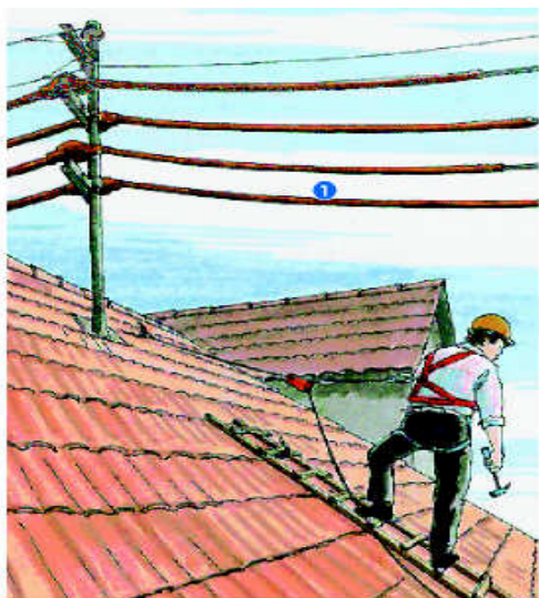
Abb. 4 Dacharbeiten in der Nähe von Niederspannungsfreileitungen
